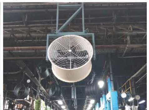
Specific spot cooling เติมลมเฉพาะจุด
