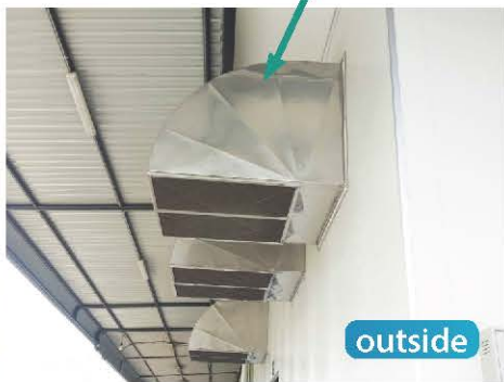
Intake fresh air from outside เติมอากาศใหม่เข้าสู่อาคาร
